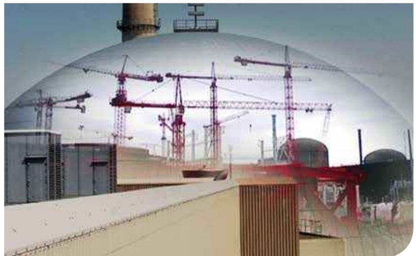
Auch nach Fukushima werden weltweit neue Atomkraftwerke gebaut
